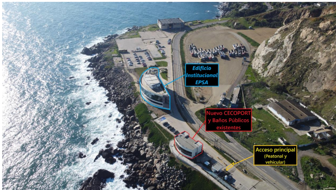
Figura 2: Vista general emplazamiento proyecto CECOPORT.
