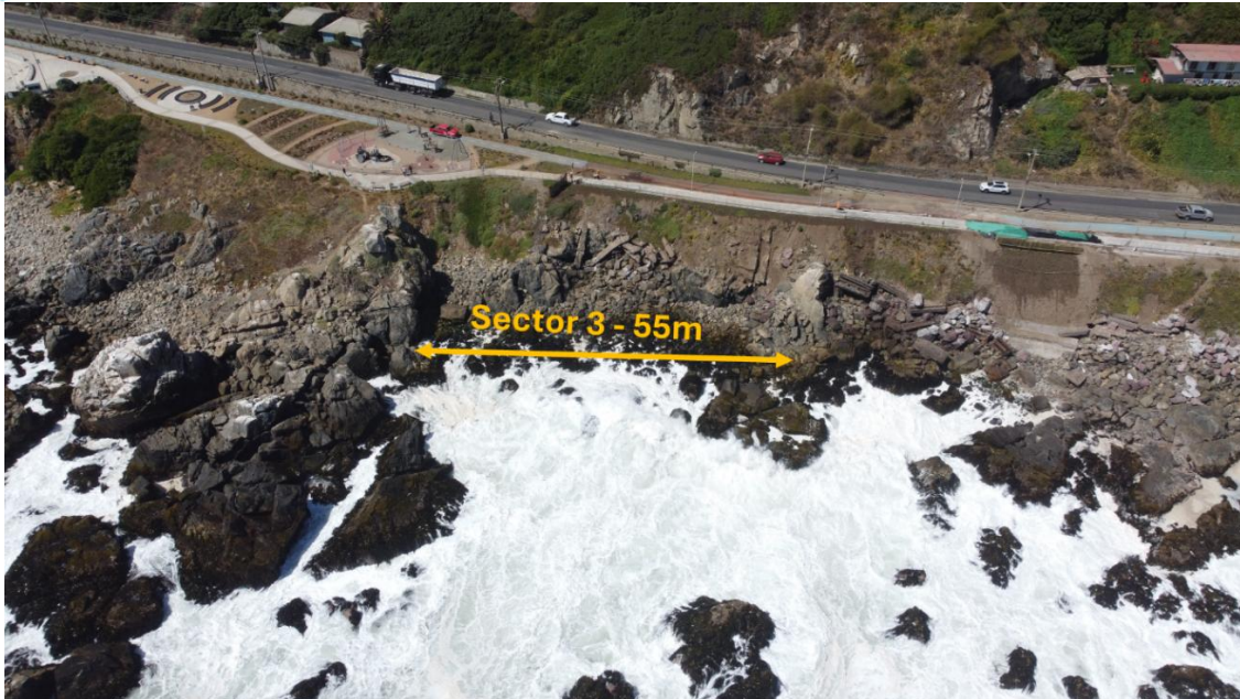
Figura 3: Vista general emplazamiento Sector 3.
