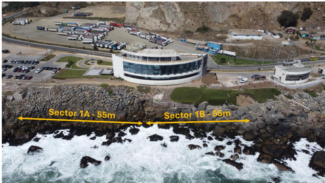
Figura 2: Vista general emplazamiento Sector 1.
