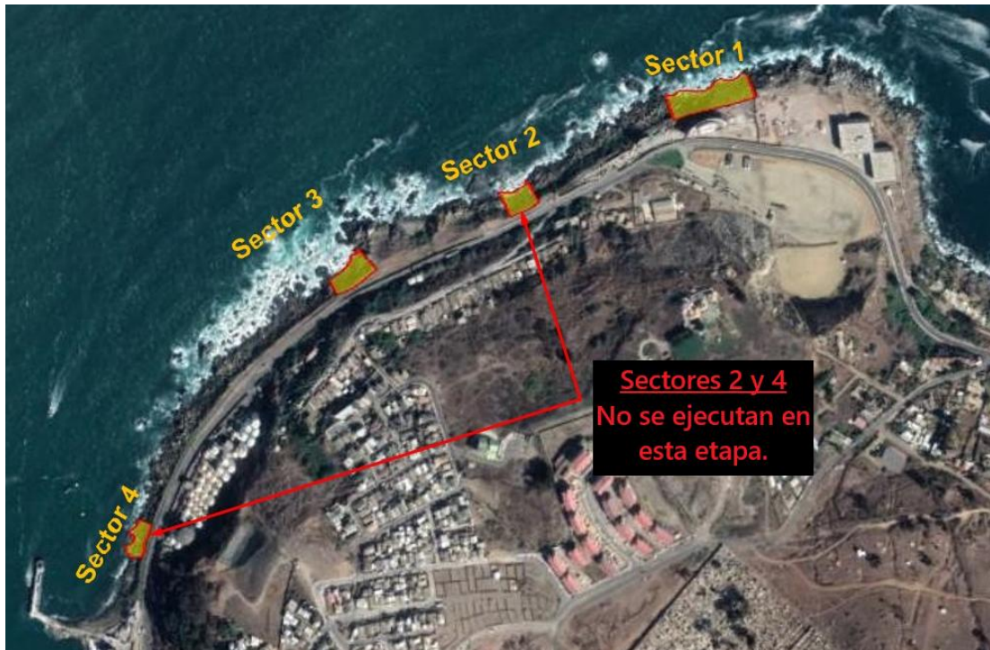
Figura 1: Vista general de la Zona de Obras.
